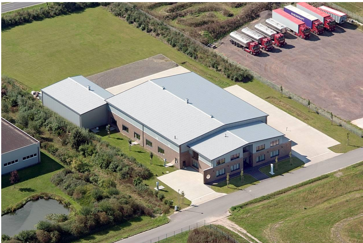
Bild 2: Neubau Firma Lars Saffe, Zerspanungstechnik GmbH in 27327 Martfeld
