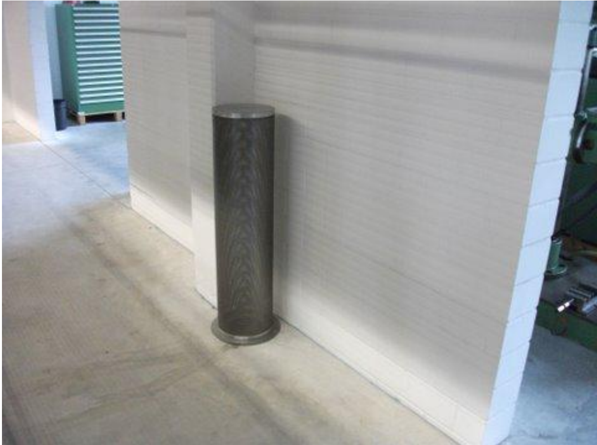
Bild 4: Einströmdiffusor bringt zugfreie, kältere Frischluft in die Fertigung.
