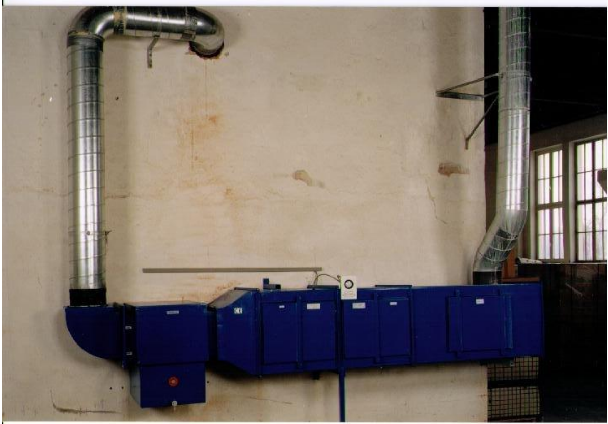
Kombinierte Filteranlage für das Ausfiltern von Silikonnebel.
